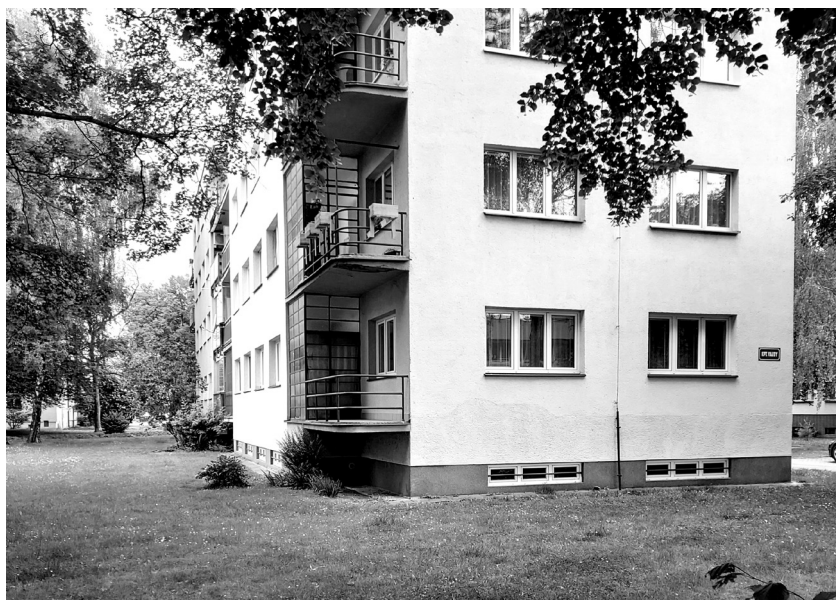
Obr. 1: Ostrava-jih, sídliště Bělský les, výstavba u ulice kapitána Vajdy.
