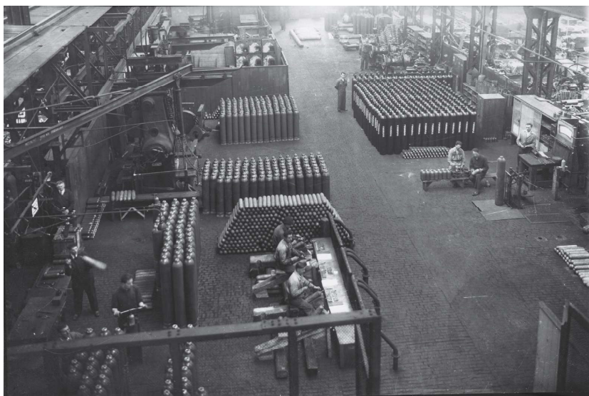
Obr. 1: Opracování ocelových lahví ve strojárně v roce 1938. Výrobní technologie se do 2. poloviny 50. let nezměnila. AV, fond Vítkovické horní a hutní těžšířstvo-Foto 18x24, č. 11025.
