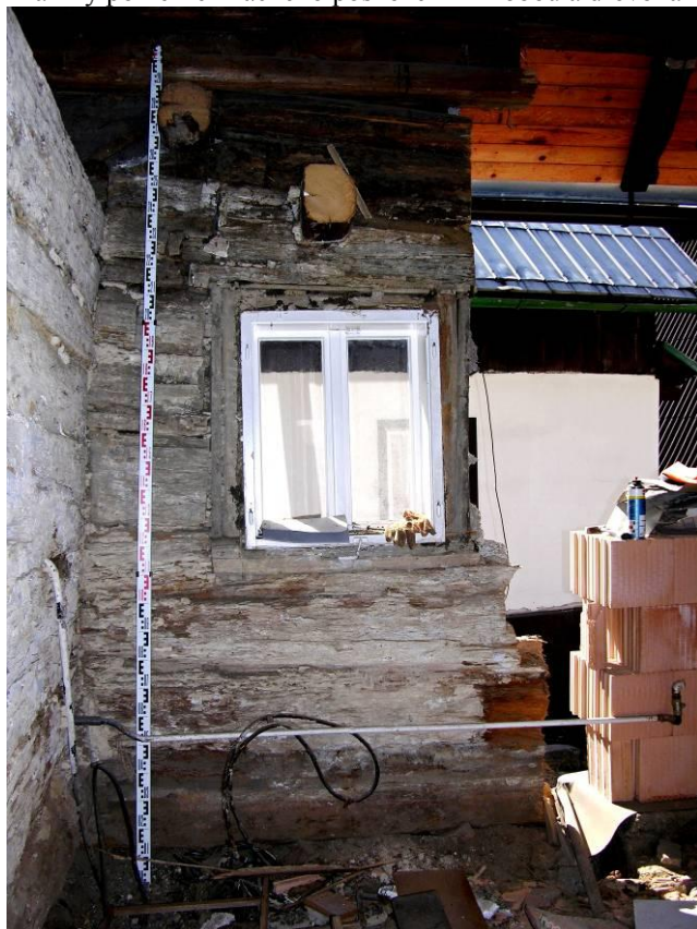
9. Pohled na část jihovýchodní stěny přední světnice domu č. p. 422 ve Štamberku během rekonstrukce (Foto J. Koudelová, 2010)
