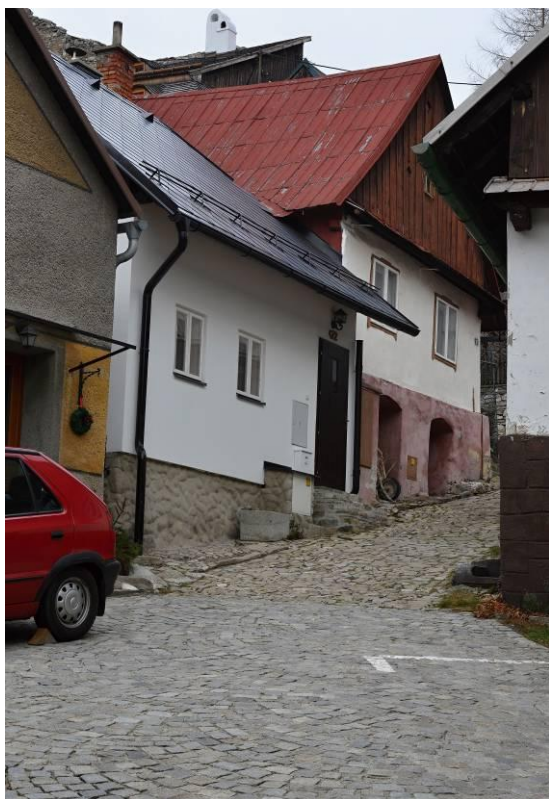
14. Pohled na dům č. p. 422 ve Štramberku po rekonstrukci (Foto J. Koudelová, 2012)
