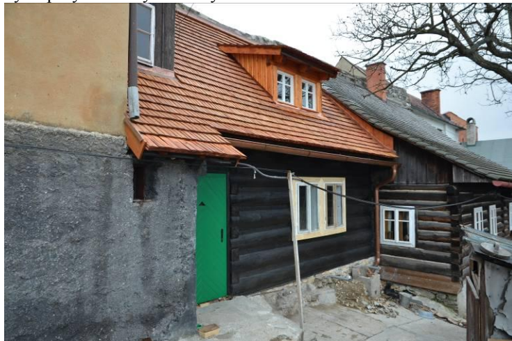
6. Pohled na zrekonstruovanou světnici domu č. p. 420 ve Štamberku (Foto J. Koudelová, 2012)
